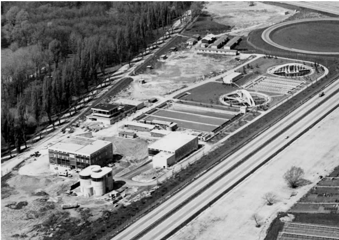
Achèvement de la STEP, 1966: le bâtiment de service est en chantier alors que la station d'épuration est déjà en fonctionnement (AVL/Photo Corninboeuf).
