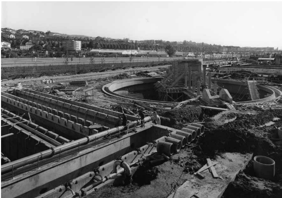
Chantier de la STEP : construction des décanteurs secondaires, 1963 (AVL).
