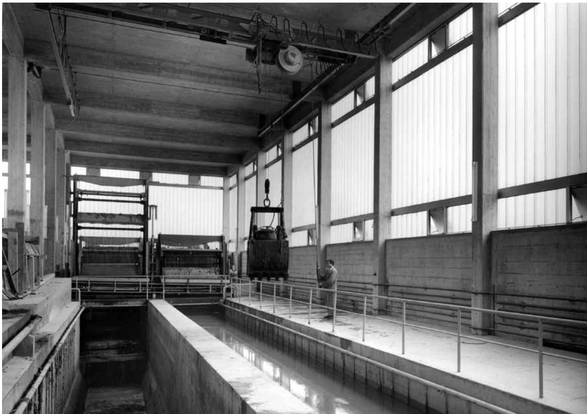
Opération de dessablage (AVL/Photo M. Vulliemin).
