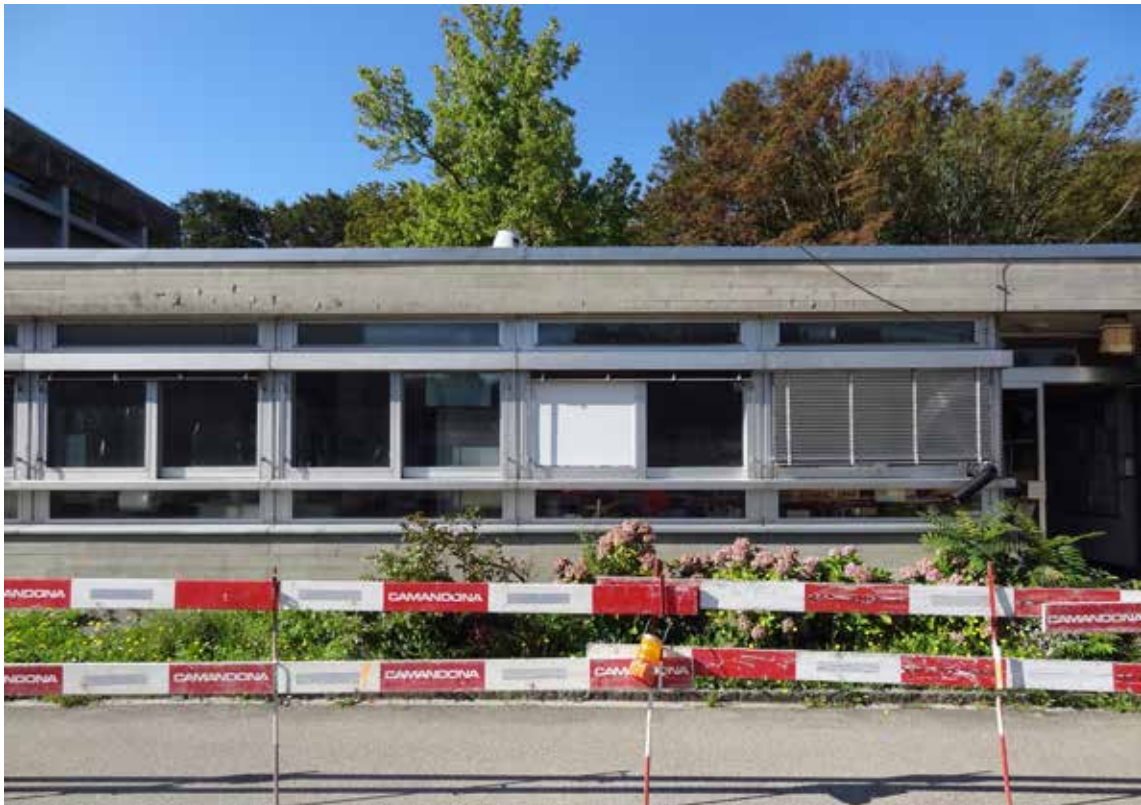
Fragment de la façade nord (photo Y. Delemontey, 2019).
