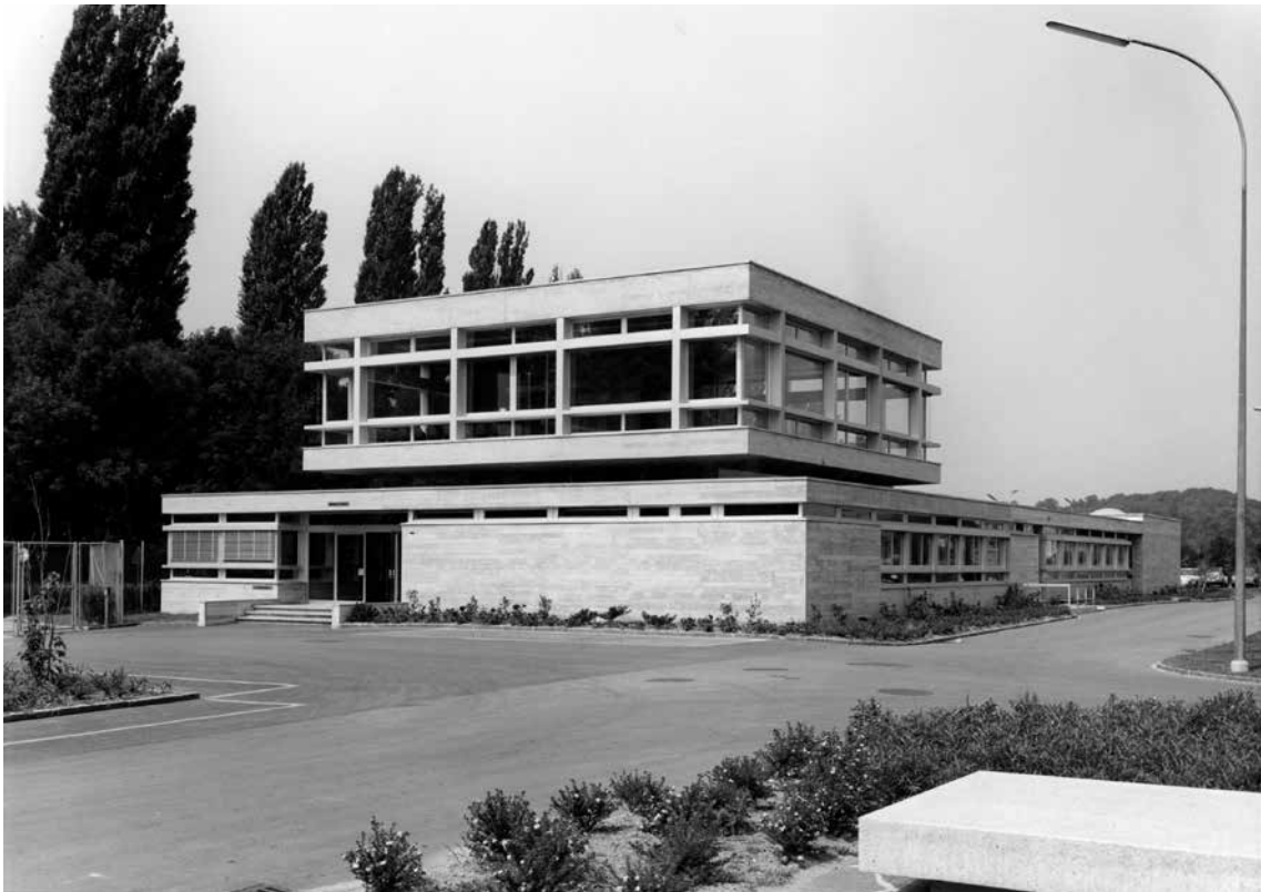
Vue du bâtiment de service depuis le bassin d'agrément situé près de l'entrée de la STEP (AVL/Photo M. Vulliemin).
