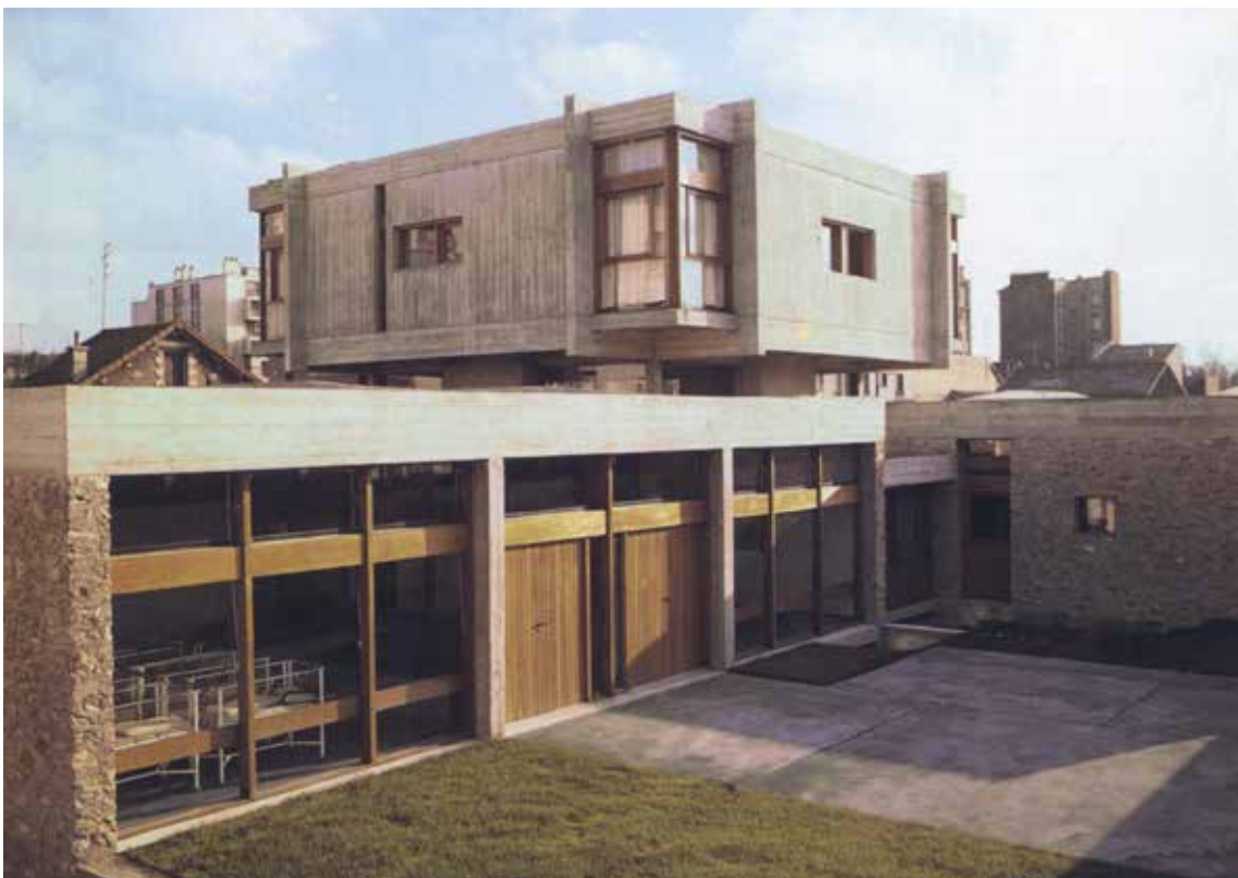
Crèche départementale de Montrouge (1959-1964), Atelier de Montrouge arch. : comme à Vidy, ce bâtiment construit dans les mêmes années exprime un bloc haut suspendu et détaché du socle constituant le rez-de-chaussée (SIAF/Cité de l'architecture et du patrimoine/Archives d'architecture du XXe siècle).
