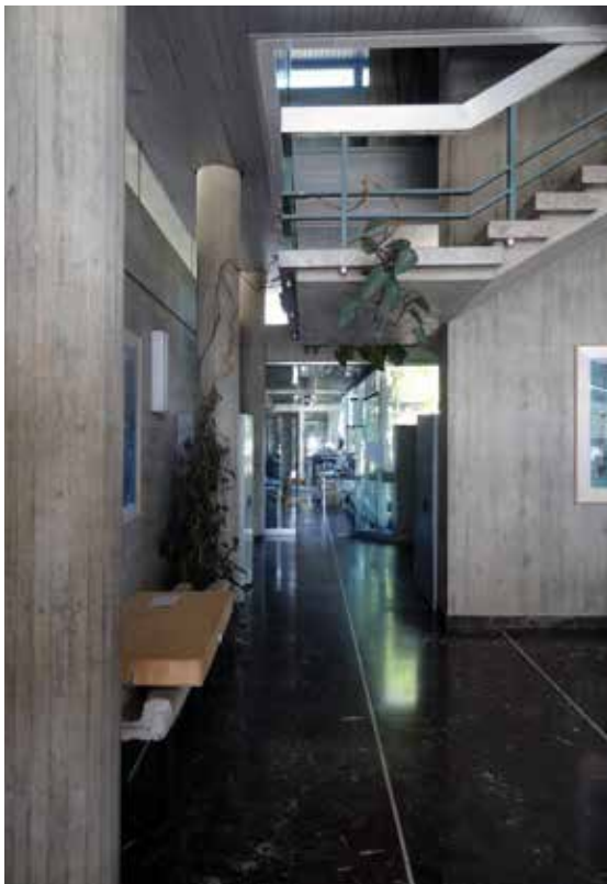
Béton brut, marbre et aluminum naturel sont les trois principaux matériaux du hall (photos Y. Delemontey, 2019).
