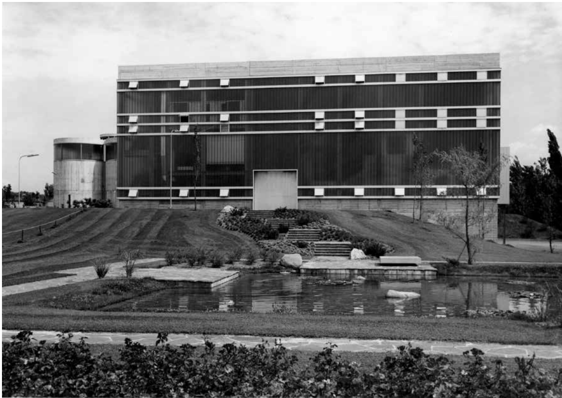
Station de déshydratation et d'incinération avec, au premier plan, le bassin d'agrément (AVL/Photo M. Vulliemin).
