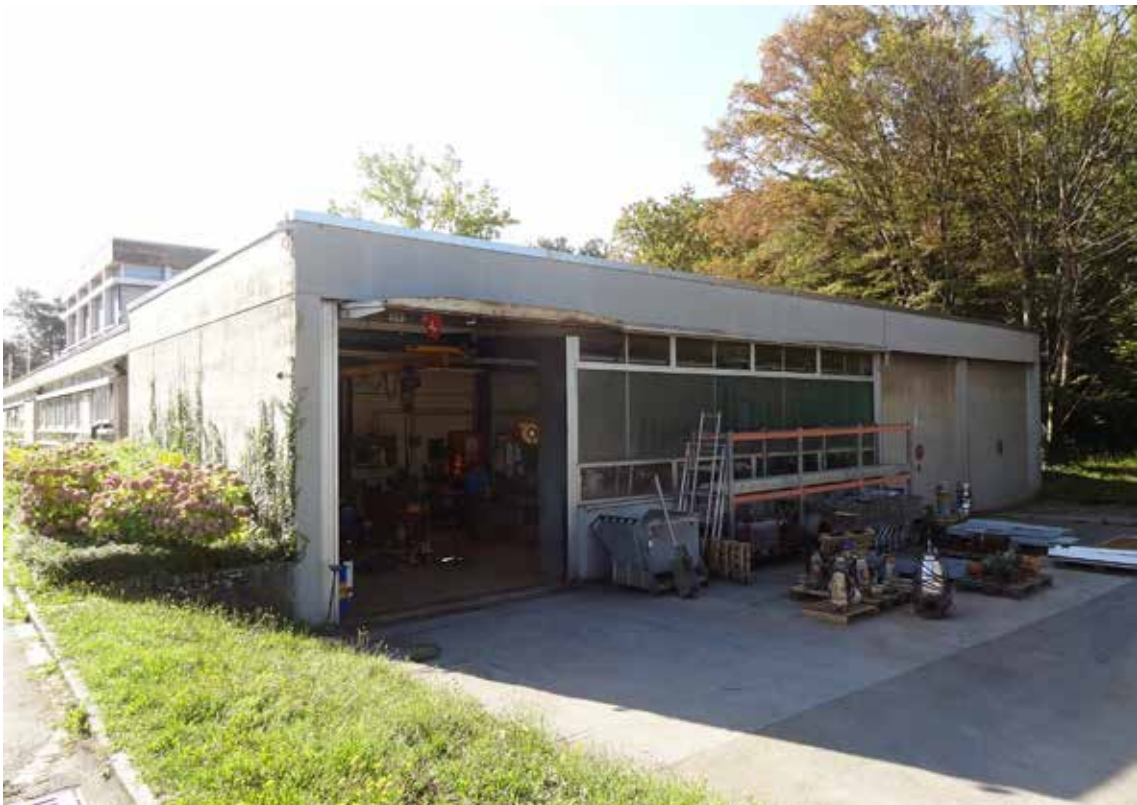
La façade ouest à l'arrière du bâtiment (photo Y. Delemontey, 2019).
