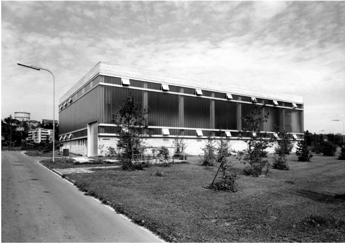
Bâtiment du dessableur-dégrilleur (AVL/Photo M. Vulliemin).
