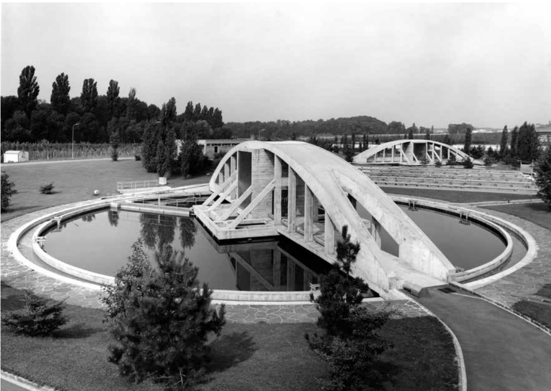
Décanteurs secondaires de type circulaire (AVL/Photo M. Vulliemin).
