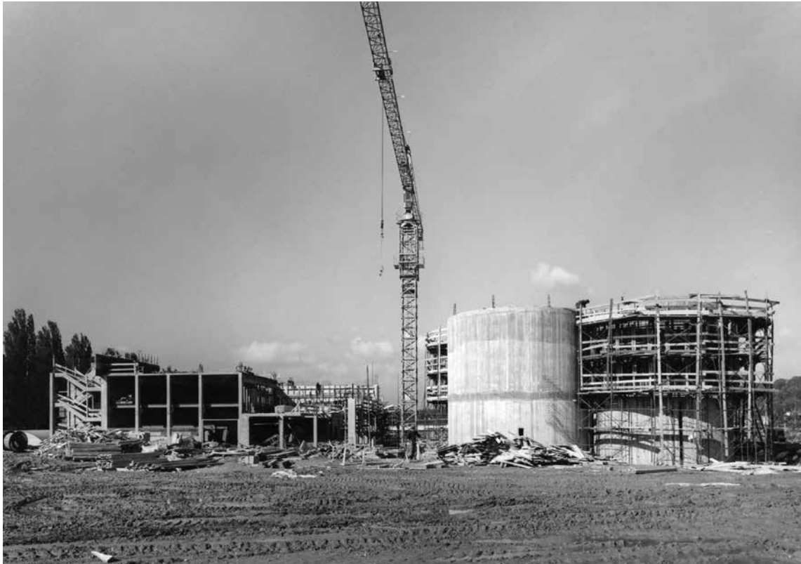
Chantier de la STEP : construction des épaisseurs primaires (à droite) et de la station de déshydratation et d'incinération (à gauche), 1963 (AVL).
