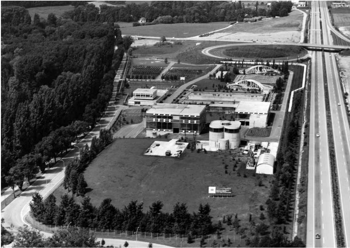
Vue aérienne de la STEP achevée, vers 1969 (AVL/Photo M. Vulliemin).
