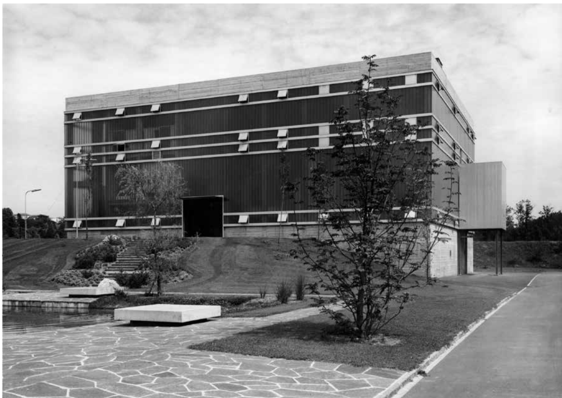
Station de déshydratation et d'incinération (AVL/Photo M. Vulliemin).
