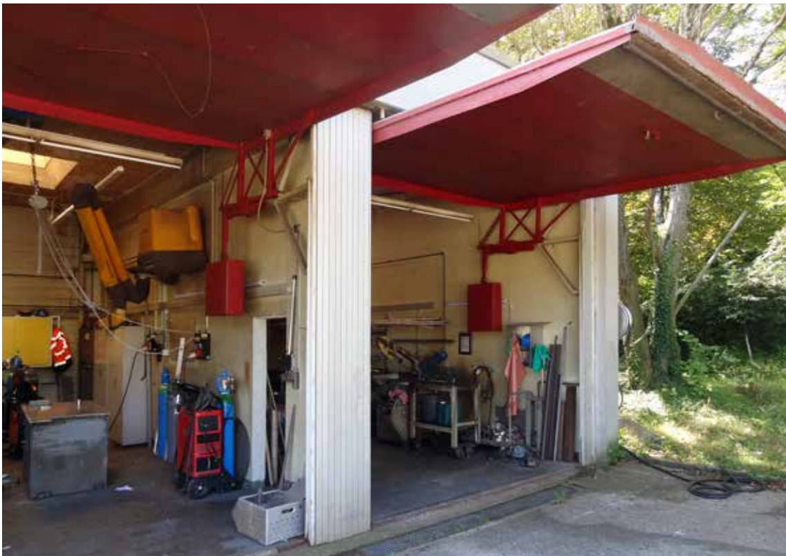
Portes de garage basculantes (photo Y. Delemontey, 2019).
