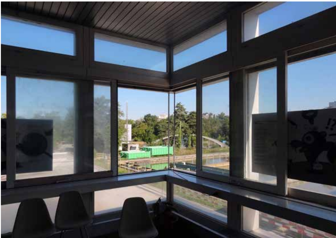
Ouverture complète de l'angle vitré avec vue sur la STEP (photo Y. Delemontey, 2019).
