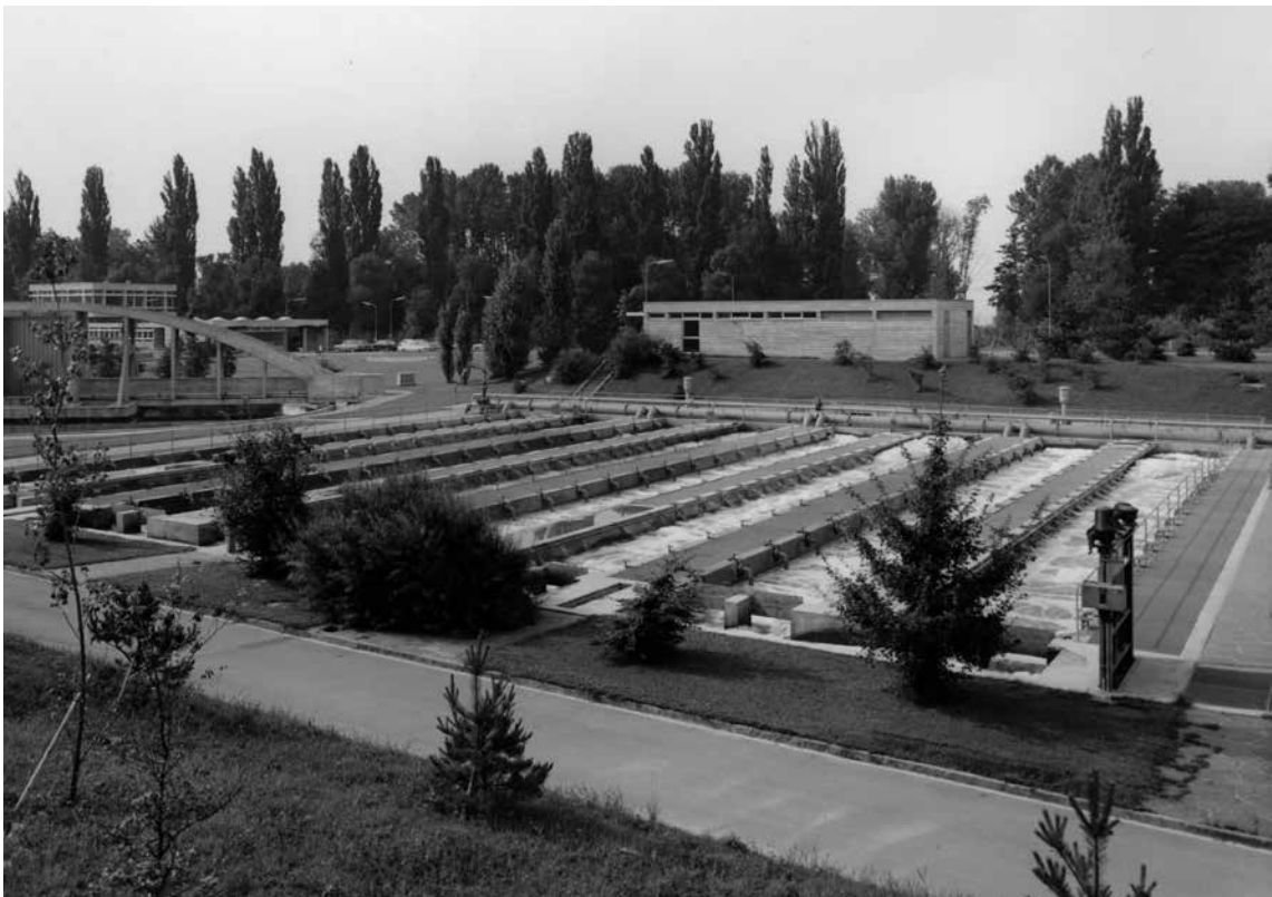
Bassins d'aération (AVL/Photo M. Vulliemin).
