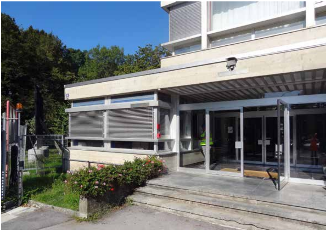
L'entrée du bâtiment de service (photo Y. Delemontey, 2019).
