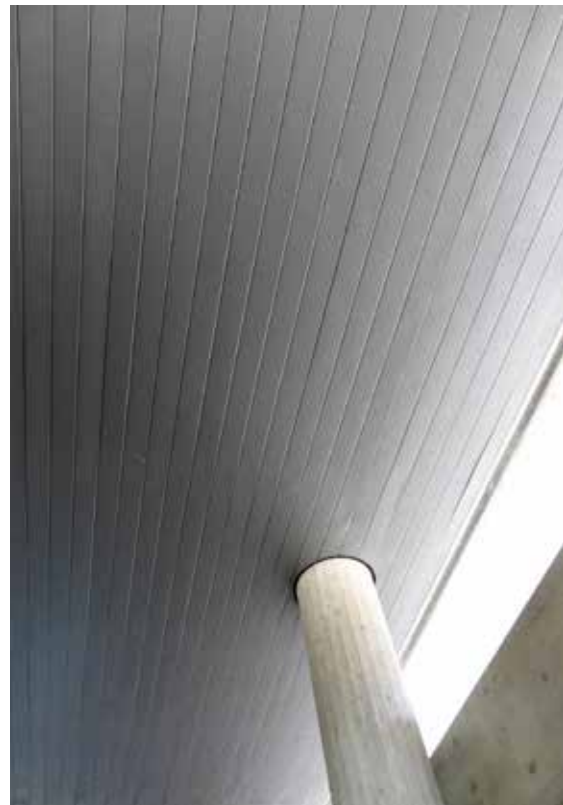
Béton brut, marbre et aluminum naturel sont les trois principaux matériaux du hall (photos Y. Delemontey, 2019).
