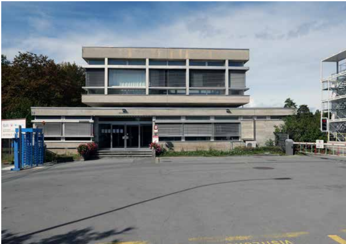
Le bâtiment de service depuis l'entrée de la STEP. Les trois ouvertures à droite au rez-de-chaussée ont été ajoutées en 1988 (photo Y. Delemontey, 2019).
