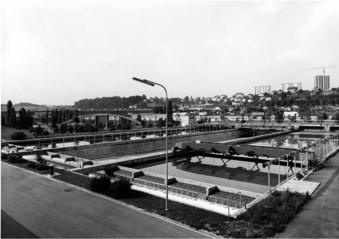
Bassins de décantation primaire (AVL/Photo M. Vulliemin).
