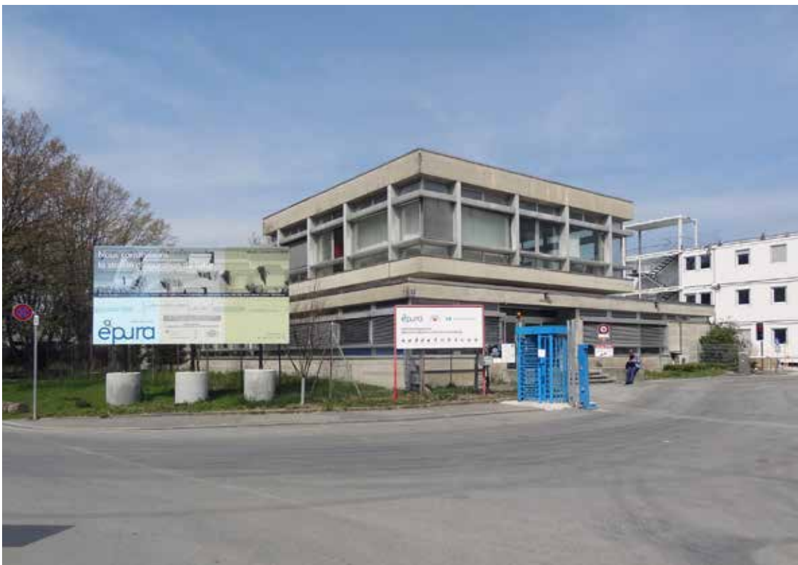
Le bâtiment de service depuis la route de Vidy (photo Y. Delemontey, 2019).
